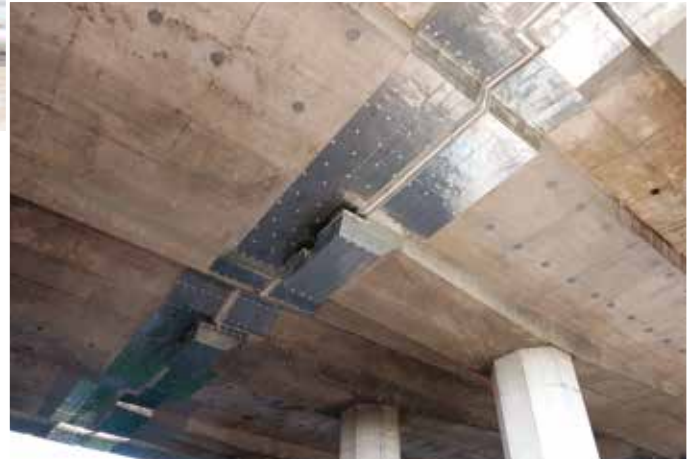
9. Vista d'insieme del giunto protetto con la lamina di zinco autoadesiva Mapeshield E45
