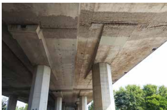
5. Il supporto in corrispondenza dei giunti preparato mediante idroscarifica manuale
