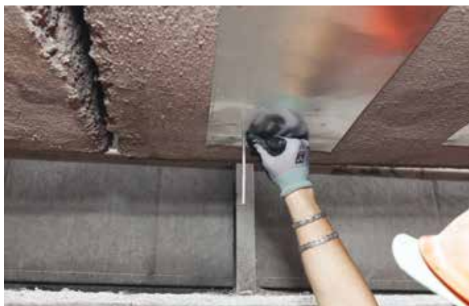
8. Un particolare del collegamento realizzato mediante barra zincata saldata alle armature preesistenti
