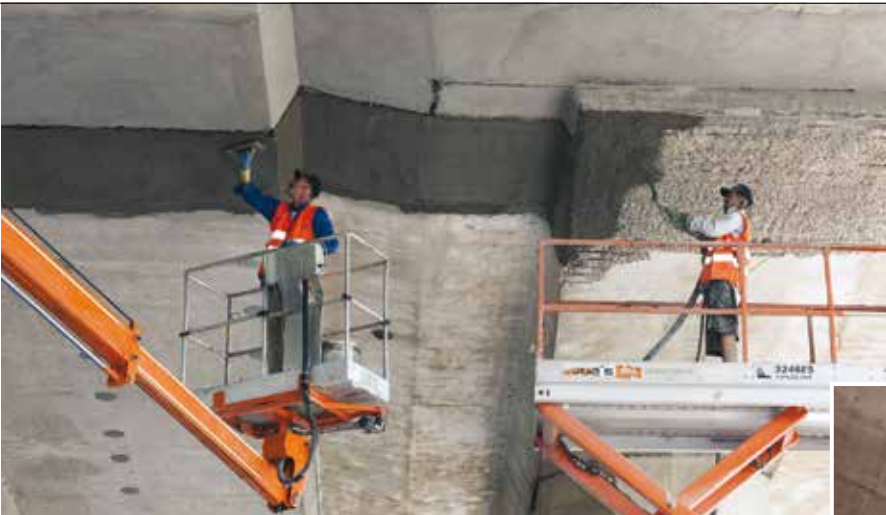
7. L'applicazione a spruzzo di Mapegrout Easy Flow e la successiva rifinitura mediante frattazzo
