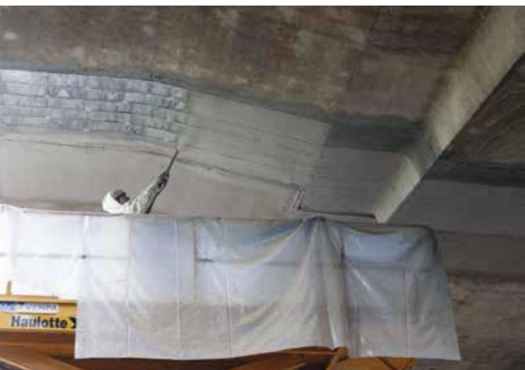
11. L'applicazione a spruzzo di Mapelastic Guard, mediante intonacatrice dotata di ugello per rasature
