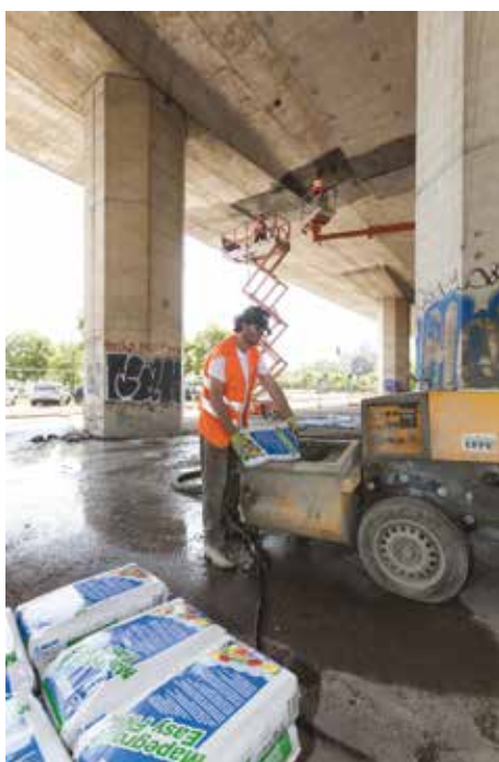
6. La miscelazione di Mapegrout Easy Flow, mediante macchina intonacatrice dotata di premiscelatore
