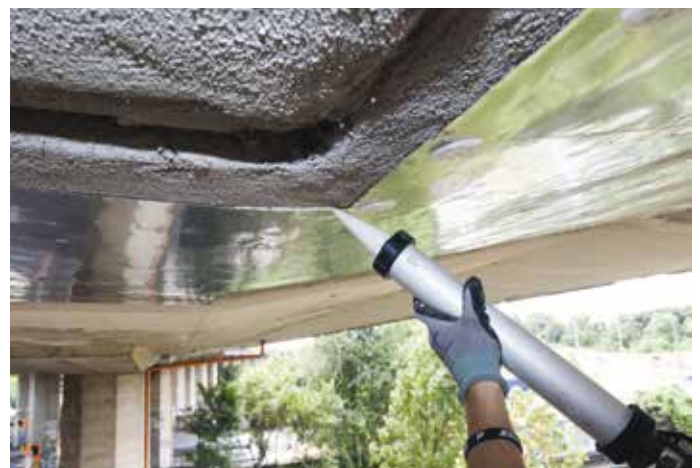
10. La sigillatura dei bordi esterni delle lamine con Mapeflex PU45
